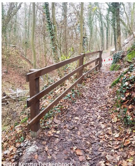
Beim Aufgang zum triefenden Stein wurden die inzwischen morsch gewordenen Stützen und Balken abmontiert und durch neue ersetzt. Somit ist wieder eine sichere Begehung möglich.
